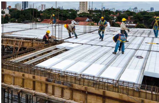
Preparación de losa.
