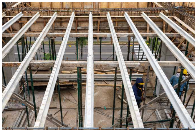
Colocado entre ejes de viguetas.
