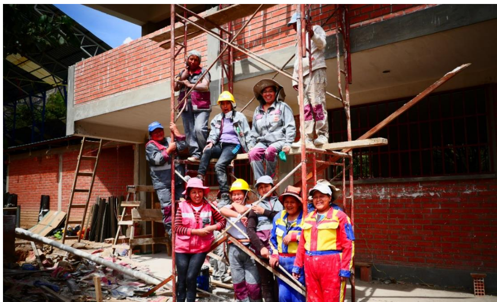
Fotografía 1: Mujeres constructoras de La Paz y El Alto en obra, trabajo de pintura
