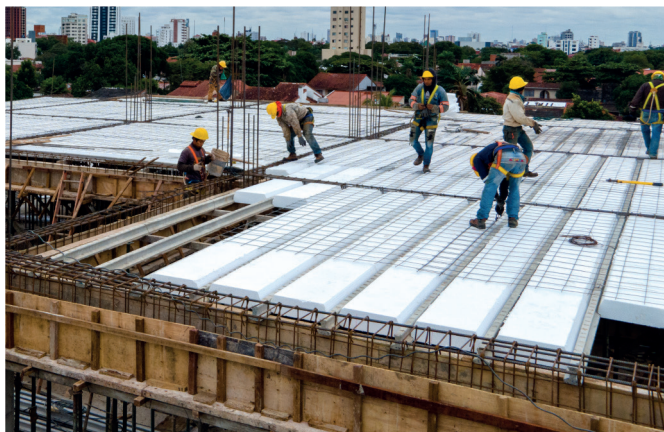
Preparación de losa.
