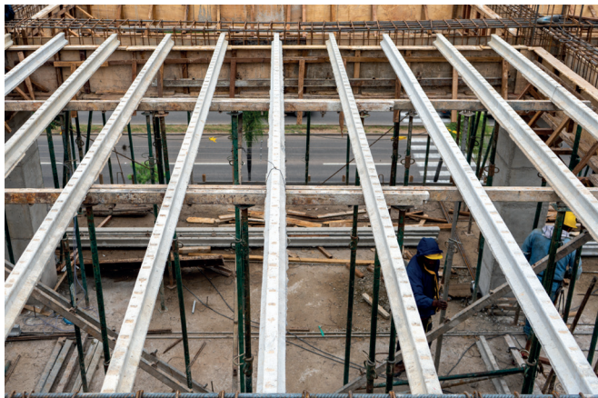
Colocado entre ejes de viguetas.
